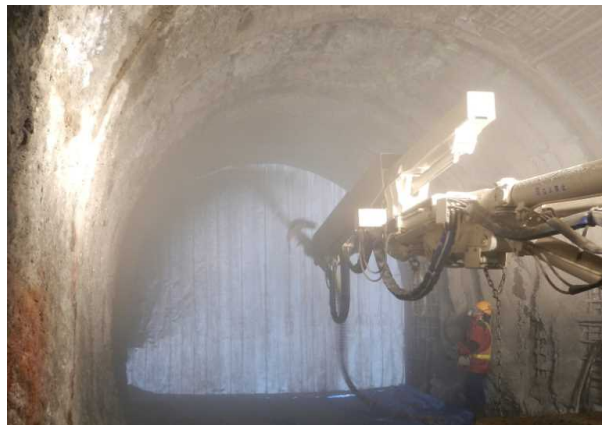
写真-1 ケースCの吹付け状況
