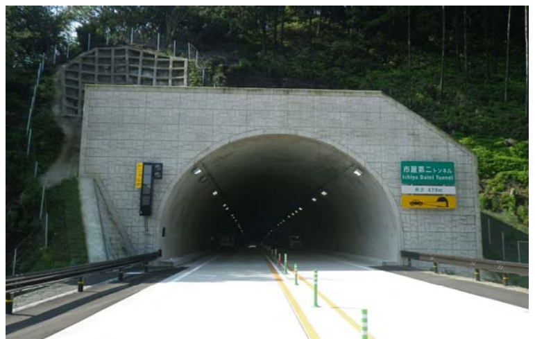
写真2 市屋第二トンネル完成写真(終点側坑口)
