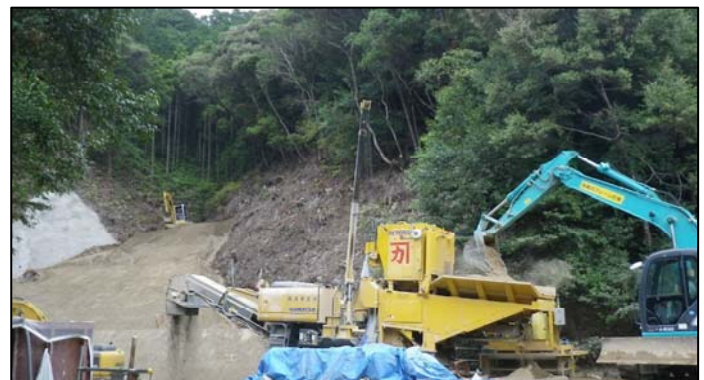
写真1 GR ソイメント工法
