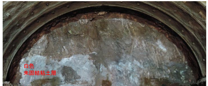
写真1 切羽状況 (No.41+15)
