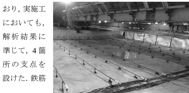
写真-1 インバート鉄筋組立架台
