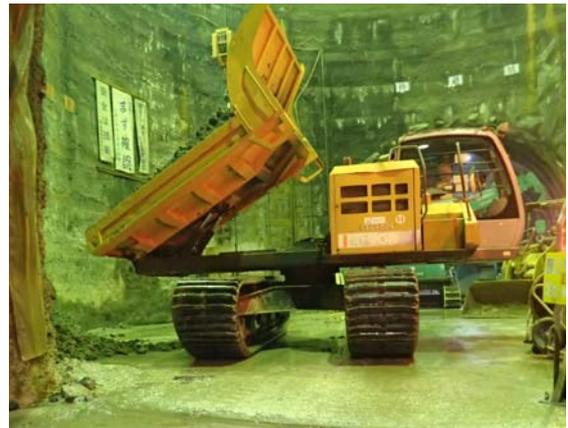
写真-2 掘削土荷下し状況(立坑底盤部)
