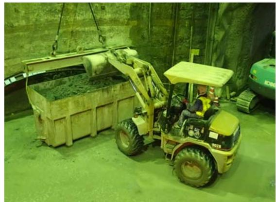
写真-3 掘削土積込状況(立坑底盤部)
