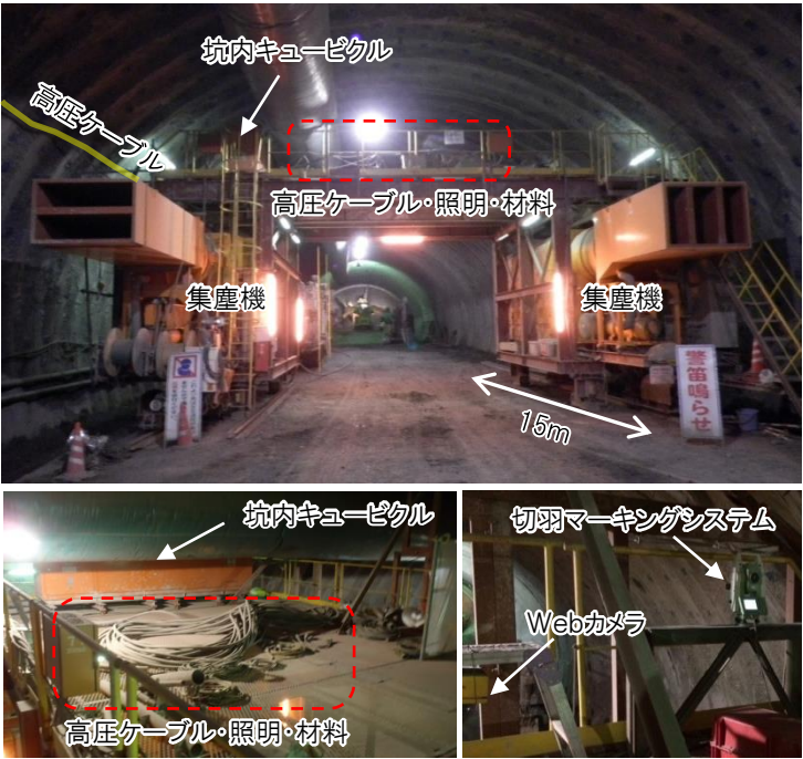
写真-1 設備・機械等、設備台車搭載状況
