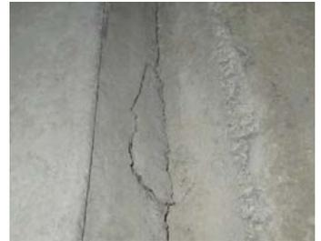
写真-1 打継ぎ目地部のひび割れ状況 (例)
