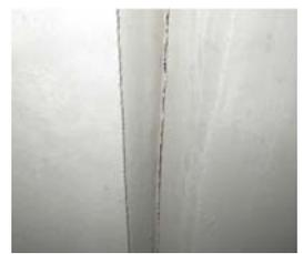
写真-7 試験施工結果 A案(合成樹脂塗料)
