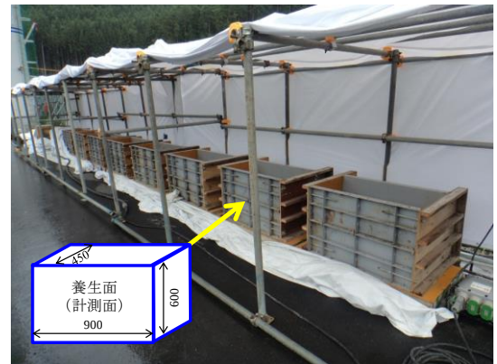
写真-1 試験体概要および型枠外観
