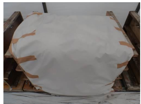
写真-2 湿潤保温シートによる養生状況
