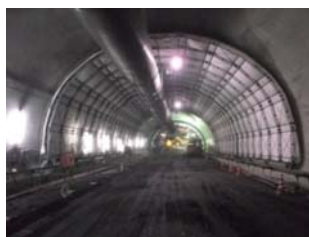
写真-1 養生システム全景
