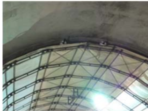
写真-8 展張状況
