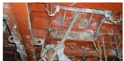
写真-1 マゴノテ工法実施状況
