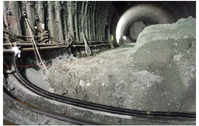
写真-2 インバートストラットへの適用事例
