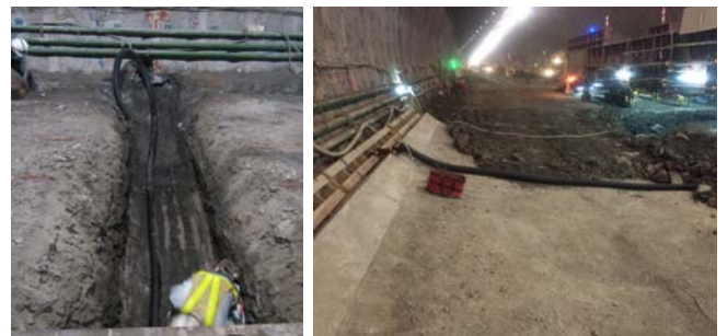
写真-3 適用状況 (左：路盤、右：インバートコンクリート)
