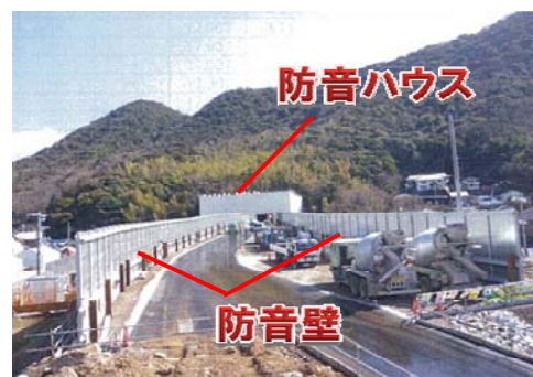
写真-1 坑口状況
