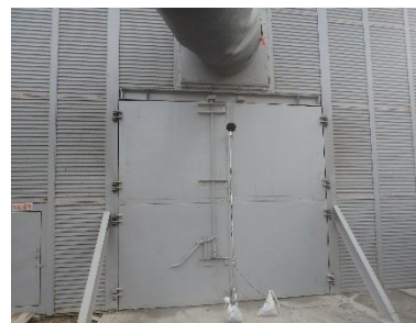
図-6 防音扉外側での計測状況
