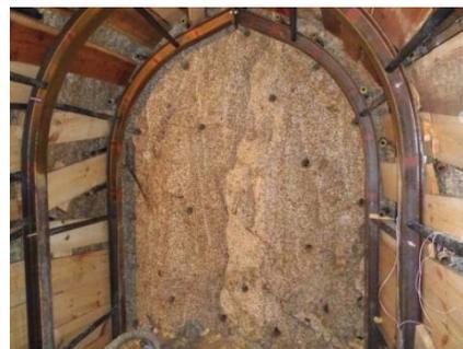
写真.1 縫地ボルト打設状況
