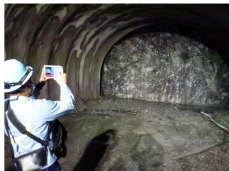
写真1 タブレット PC による切羽撮影状況
