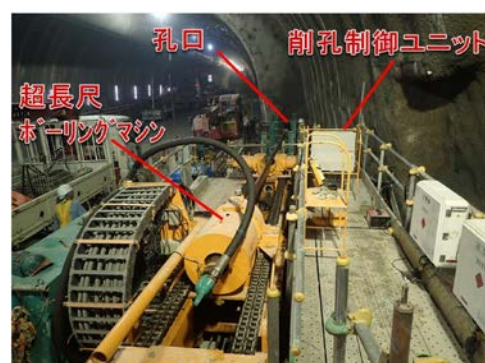
写真-1 超長尺ボーリング実施状況
