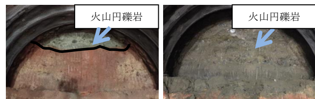
図 3 切羽写真(36km506.4m) 図 4 切羽写真(36km484.8m)
