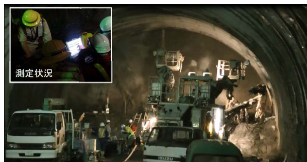
写真-1 現場実験全景
