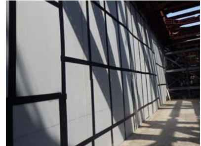
図-5 ゼロスペースボード設置後全景
