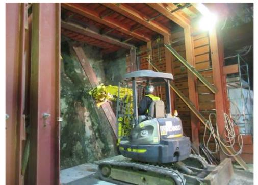
写真-4 導坑支保工の建込み状況
