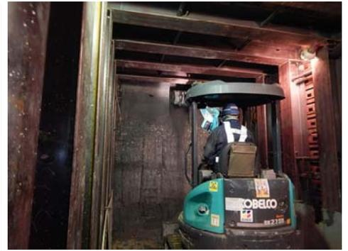
写真-2 導坑一般部の掘削状況
