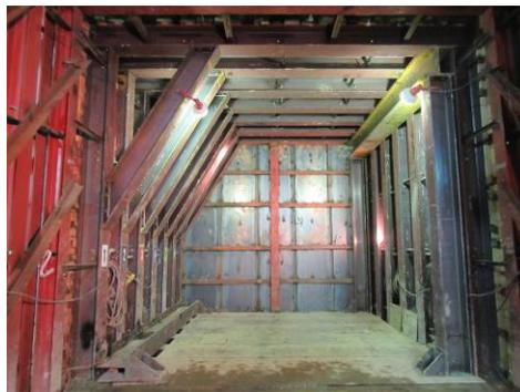
写真-1 導坑進入部の支保工
