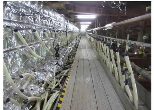
写真-3 凍結管の設置状況
