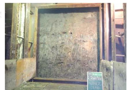
図-7 導坑掘削時の改良体切羽
