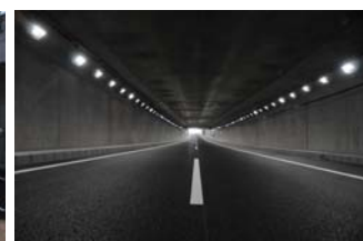
写真-6 非開削部完成写真
