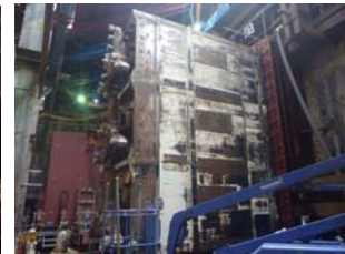
写真-1 横5連結推進機到達状況 写真-2 縦3連結推進機到達状況
