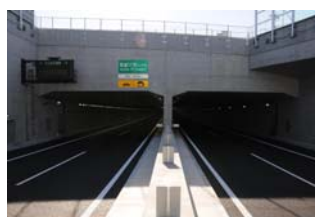
写真-5 開削部完成写真
