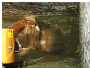
写真-3 外殻内部の掘削状況
