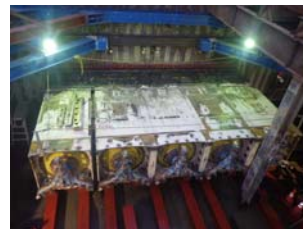
写真-1 横5連結推進機到達状況 写真-2 縦3連結推進機到達状況
