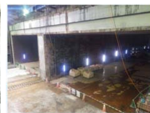
写真-4 外殻内部の掘削完了
