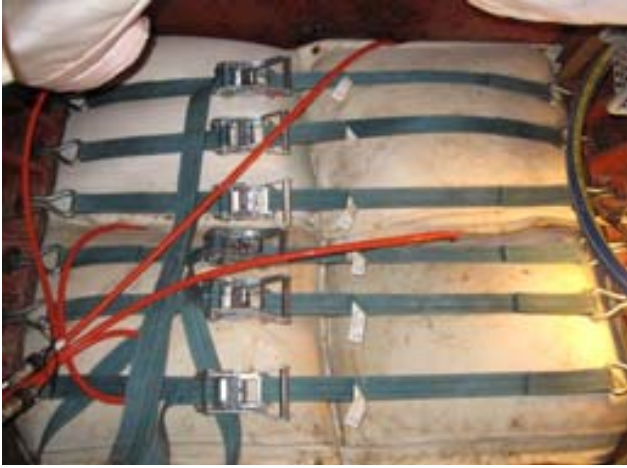
図-6 エアバック設置状況
