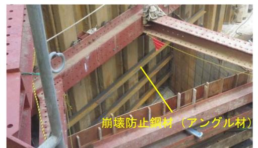
写真-5 支圧壁崩壊防止対策
