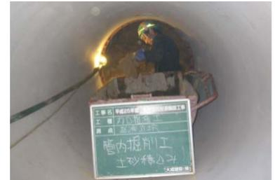
写真-4 坑内人力掘削
