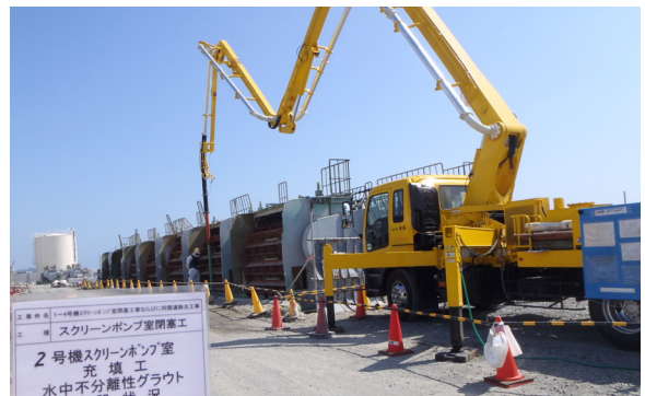
写真-1 施工状況(打込み状況)
