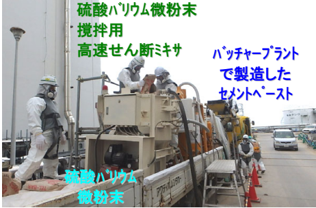
写真－２ 水中重量ペーストの施工状況
