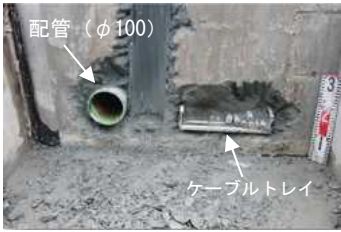
写真－4 埋設物周りへの充填状況（86m 地点）
