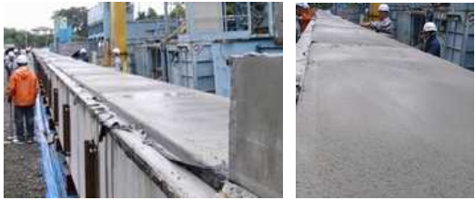
写真－3 上蓋撤去後の状況
