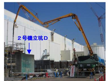
写真-1 充填材打込み状況
