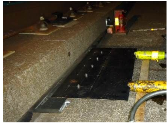
写真2 スラブマット位置整正
