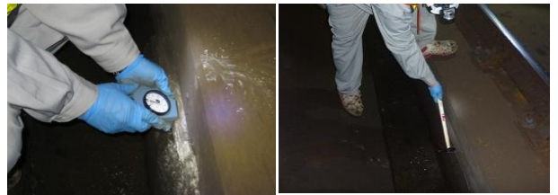
写真-1 硬度測定状況 写真-2 打音検査状況
