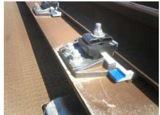
図3 鋼橋直結5形レール締結装置
