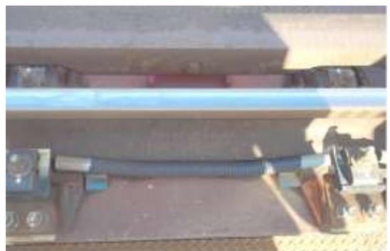
図8 絶縁性短絡防止材の敷設
