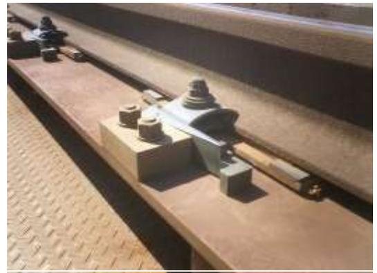
図2 鋼橋直結Ⅱ形レール締結装置
