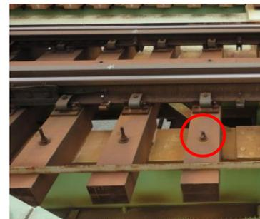
図-1 フックボルトの緩み状況
