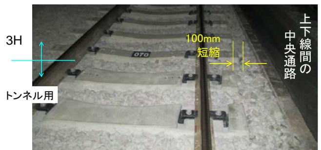
図 5 敷設したトンネル用PC(手前)と3H型PC(奥)
