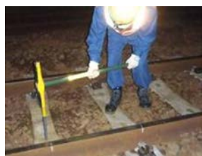
図 - 1 杭の打ち込み状況
