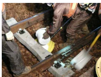
写真-5 反応材散布
