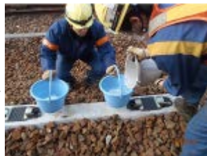
写真-2 ポリマーの注入
