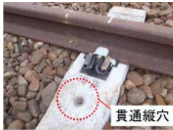
写真-1 PC まくらぎ貫通縦穴
