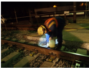
写真-1 シリコン注入
