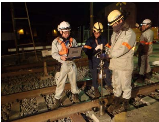
写真-2 小型FWD試験装置
