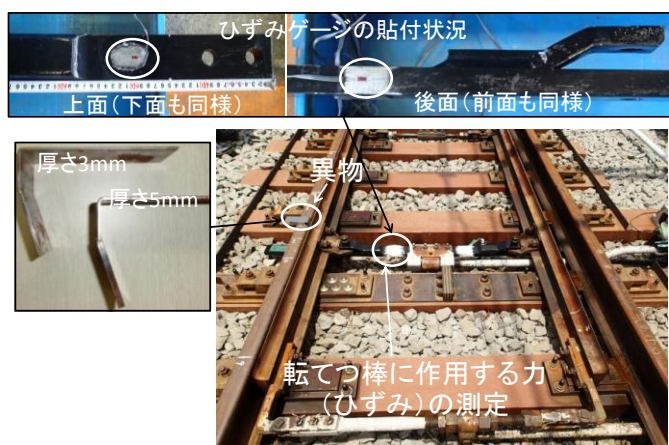
図 1 転換試験の状況およびひずみゲージの貼付状況
