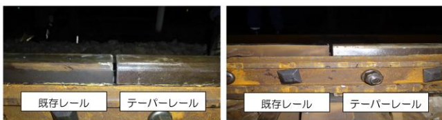
図-3 起点側継目（直線区間） 図-4 終点側継目（直線区間）
