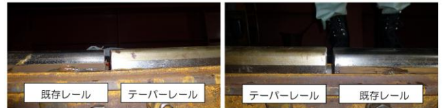
図-5 起点側継目（曲線区間）
