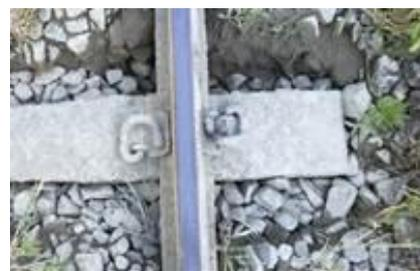
写真-3. まくらぎ肩幅露出噴泥箇所
