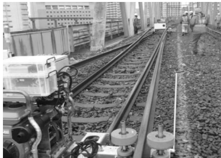
【写-2:ワイヤレスによるレール交換】
