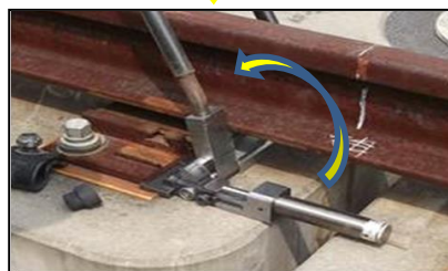
図5 レール持上げ状況
