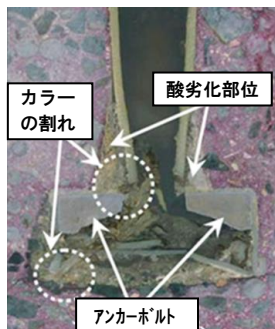
図-1 埋込栓カラー断面
