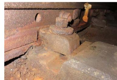
写真-3 ゴム製締結装置
