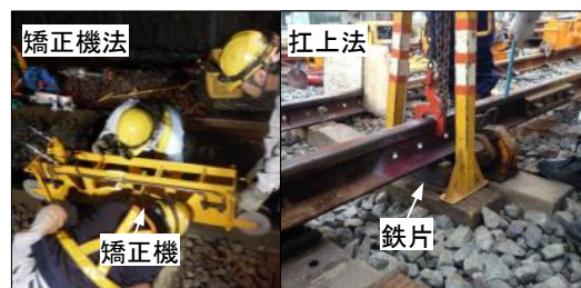
図2 2種類のレール矯正方法
