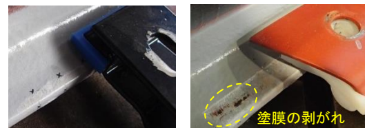
①本締結装置 ②ナブラ型 (a) 300万回载荷後の塗膜の損傷状況
