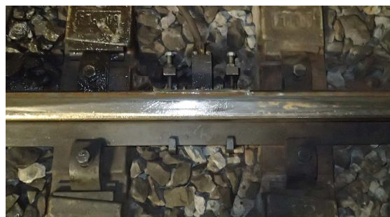
写真-1 レール研削後のレール
