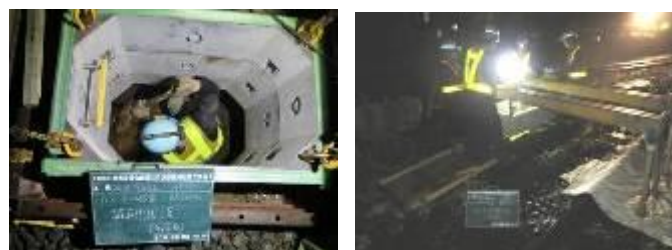
写真-1 ハンドホール施工状況
