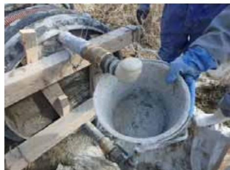
写真-2 充填完了写真
