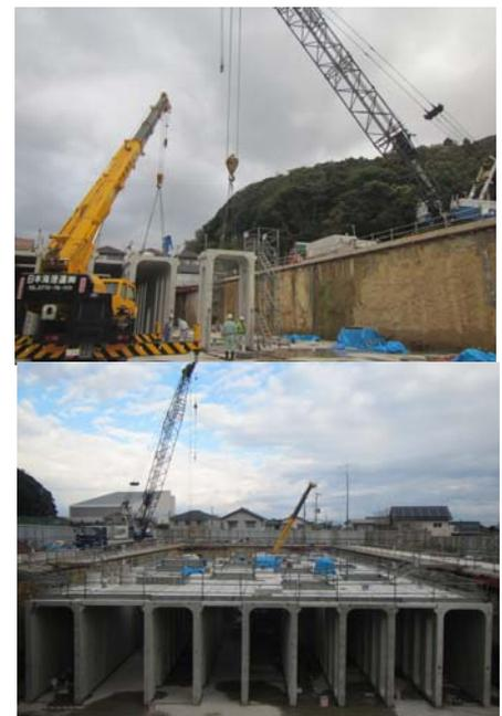
図-6 PC部材設置状況図
