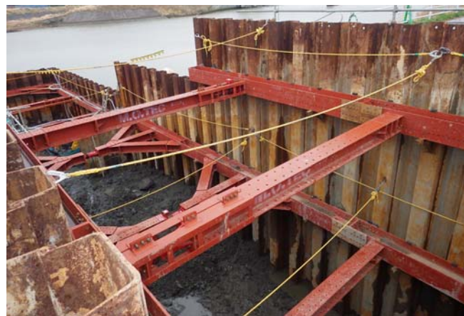
写真-3. 施工状況写真
